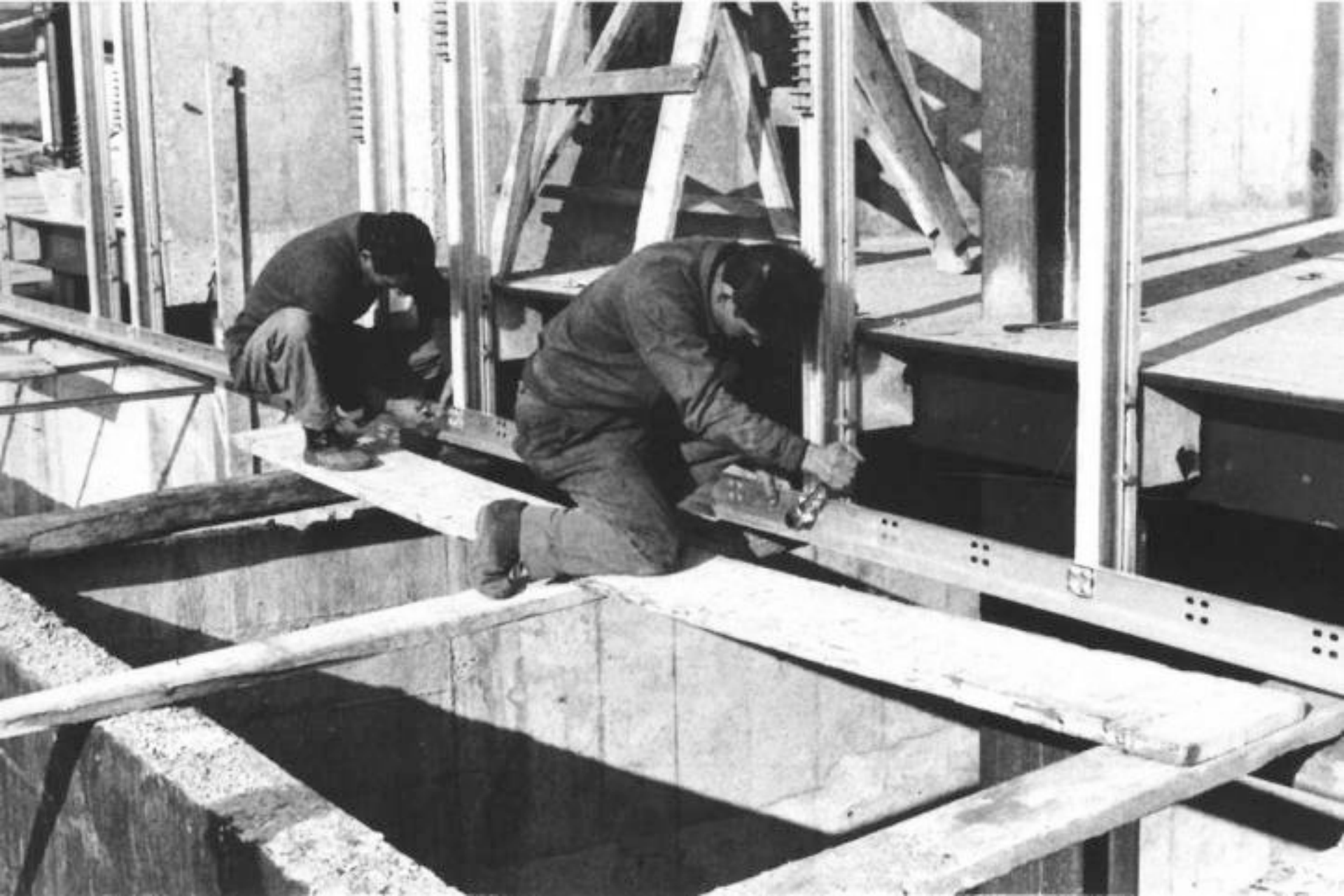
Vista del cantiere
