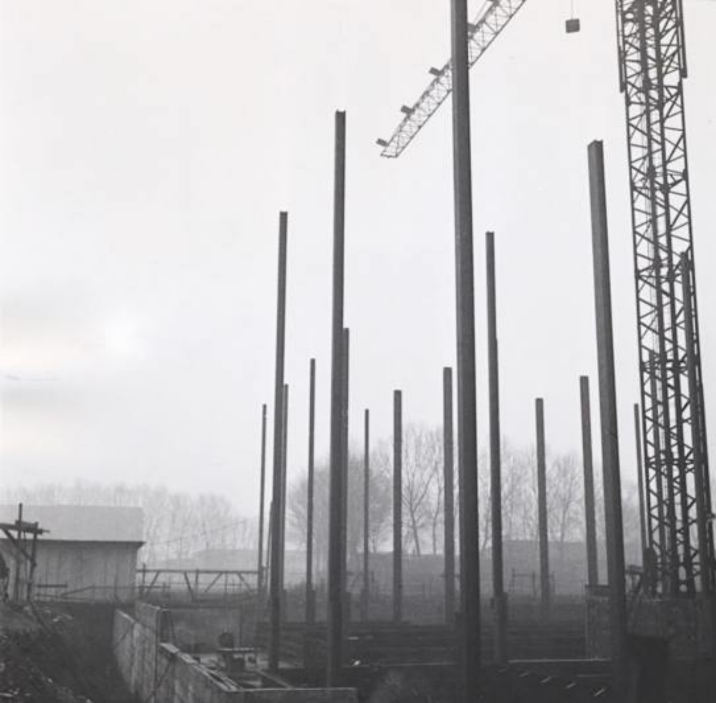
Vista del cantiere del sistema VAR/M3
