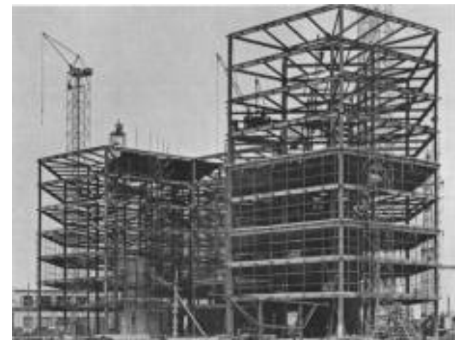
Il cantiere della prima sede ENI (1956-57)
