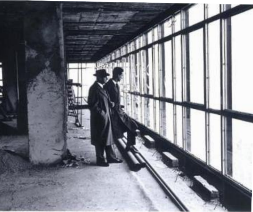
Il cantiere (AMB)
