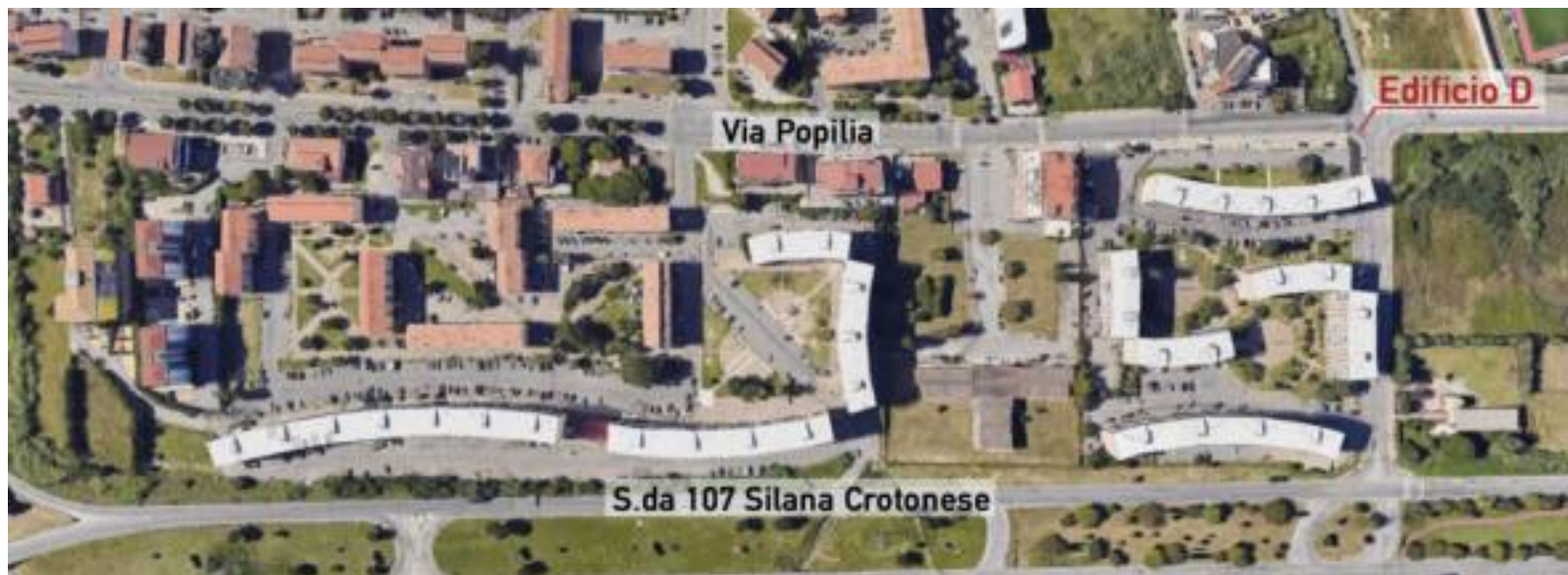
L'intervento GESCAL denominato «Lotto 3» in una veduta aere complessiva
