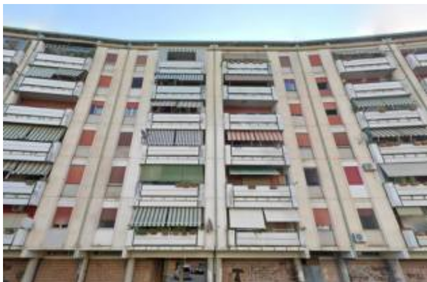
Foto di una parte del prospetto Ovest nello stato attuale
