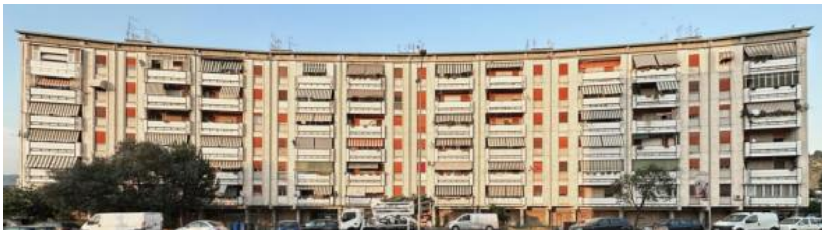
Edificio D oggetto della tesi: facciata Ovest, su Via Popilia
