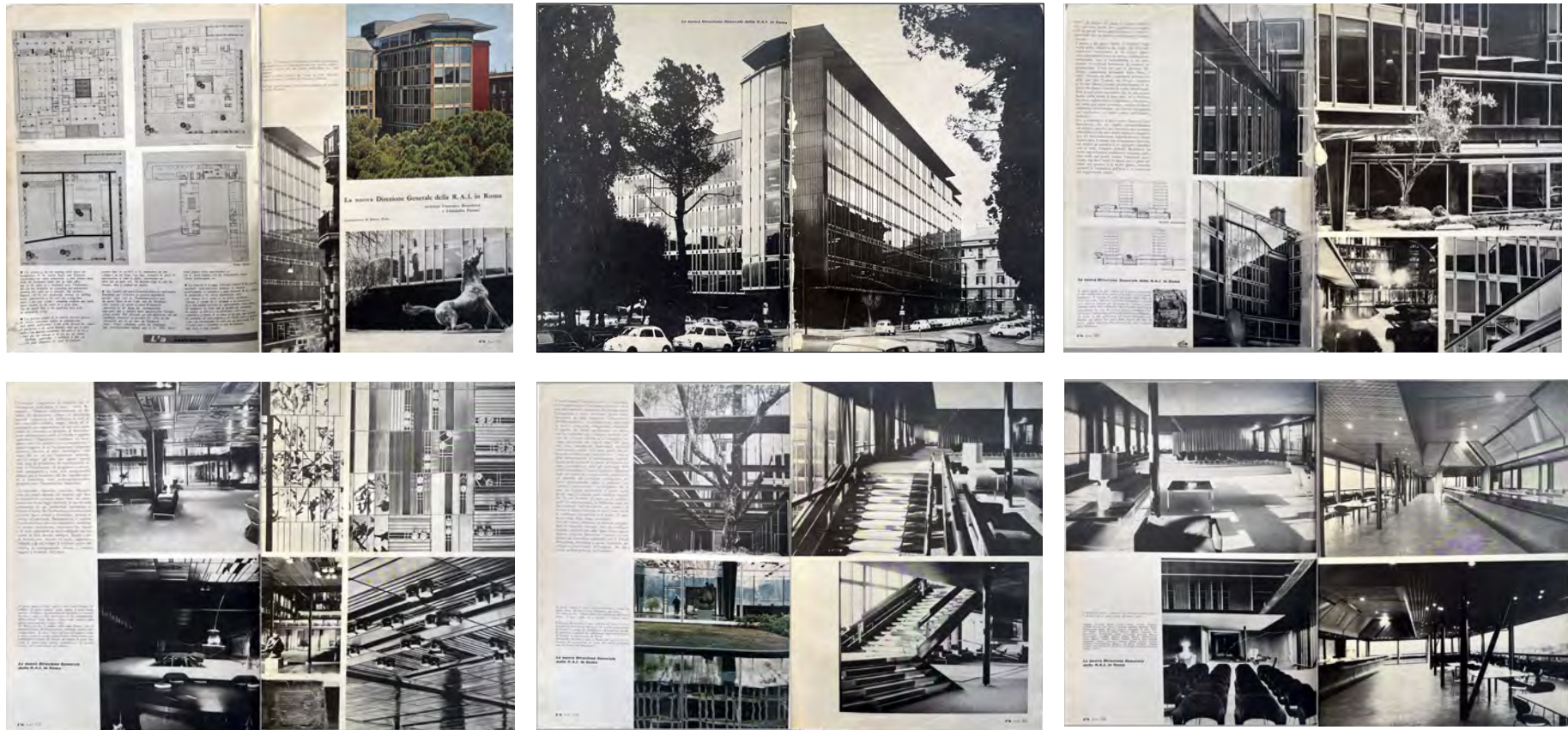
R. Pedio, «La nuova Direzione Generale della RAI in Roma» in L'Architettura Cronache e storia n.142 , agosto 1967
