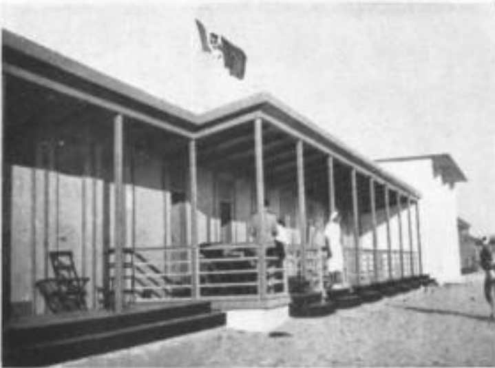
Cabine di uno stabilimento da guerra costruite con elementi Pasotti
