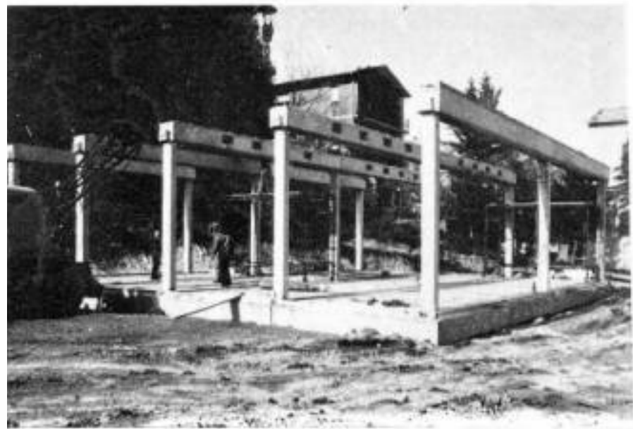
Struttura di questo edificio è in pilastri e travi di cemento armato prefabbricate, trasportate e montate in opera su fondazioni continue precostituite.
