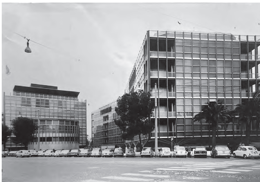
Fig. 1 - Vista del complesso (AI, faldone 1116)
