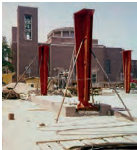
Figg. 6, 7 - La struttura in fase di montaggio. A sinistra, i pilastri cruciformi e sullo sfondo la chiesa del Sacro Cuore di Cristo Re di Marcello Piacentini; a destra, le travi forate del primo ordine per il passaggio degli impianti e i montanti tubolari più sottili del secondo ordine (AB)
