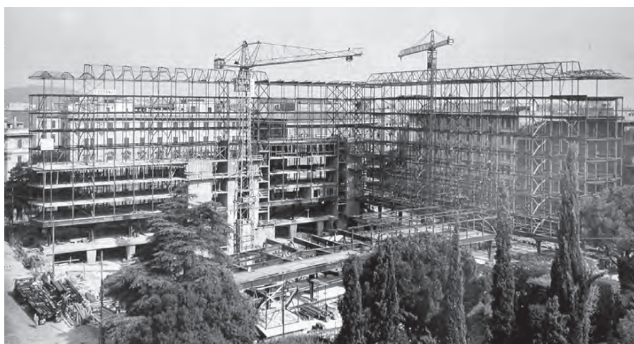
Fig. 5 - L'edificio in fase di costruzione (AB)
