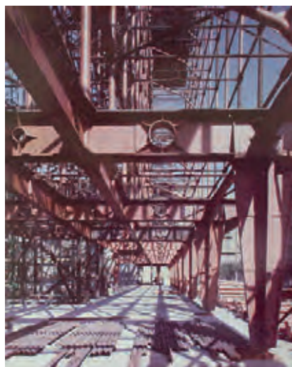
Figg. 6, 7 - La struttura in fase di montaggio. A sinistra, i pilastri cruciformi e sullo sfondo la chiesa del Sacro Cuore di Cristo Re di Marcello Piacentini; a destra, le travi forate del primo ordine per il passaggio degli impianti e i montanti tubolari più sottili del secondo ordine (AB)
