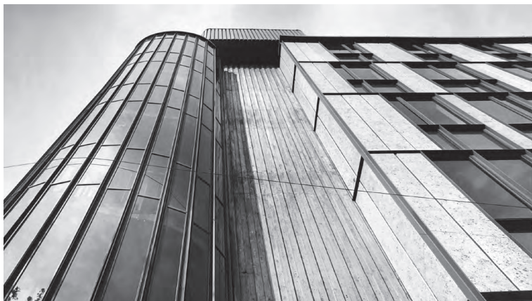
Fig. 25 - Dettaglio della facciata verso via Casilina; è visibile il corpo scala completamente vetrato (ACS, FL, b. 70)
