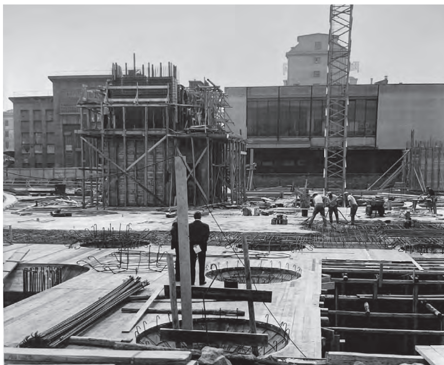
Figg. 13-16 - Viste del cantiere (ACS, FL, b. 70)
