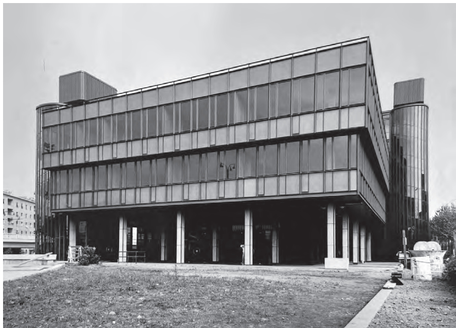
Fig. 18 - Il complesso edilizio completato (ACS, FL, b. 70)
