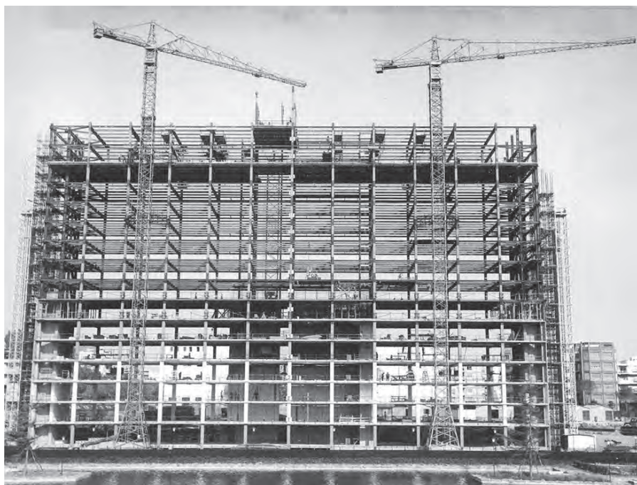
Fig. 6 - Il cantiere nel mese di giugno 1961 (ASE)
