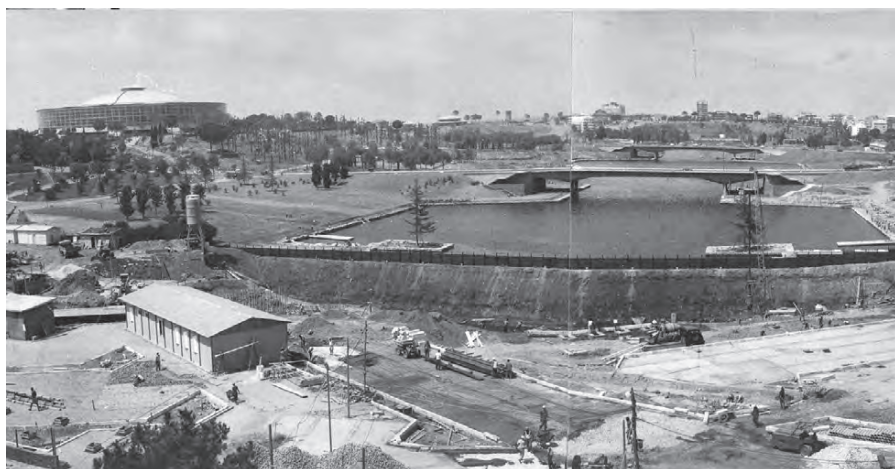
Fig. 5 - Il cantiere all'inizio dei lavori, luglio 1960 (ASE)
