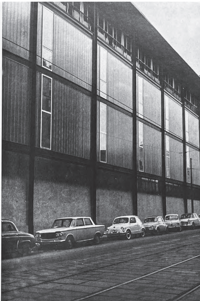
Edificio delle macchine del «Corriere della Sera» in Milano
